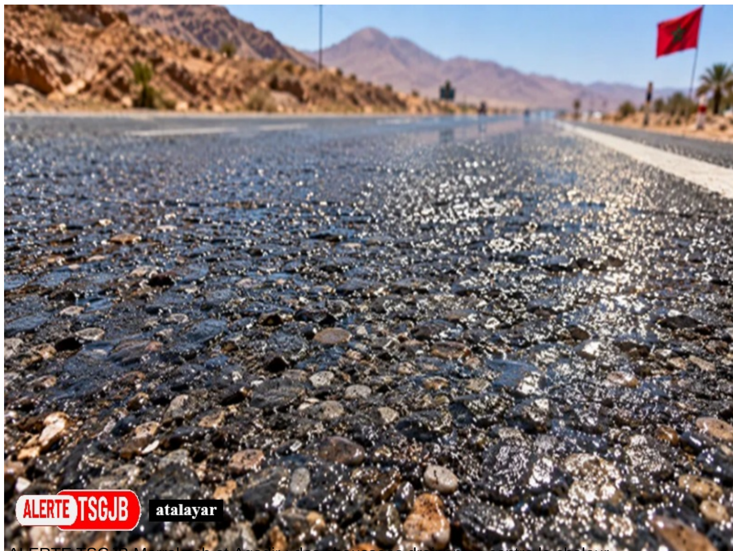
ALERTE TSGJB Marrakech et Agadir : des chaussées drainantes contre la chaleur
